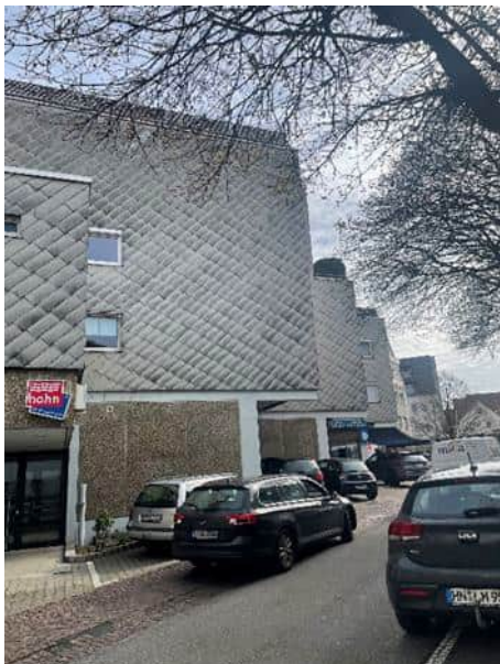
Abbildung 35: Störende und ortsfremde Gestaltung sowie Verkehrsdefizit in Mitte der Ortsmitte (Quelle: WHS, 2024)
