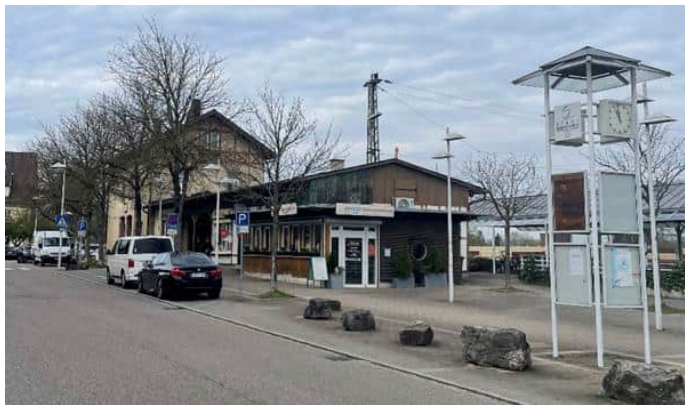
Abbildung 9: Bahnhofstraße 7, 7/1 (Bahnhofsgebäude) (Quelle: WHS, 2024)
