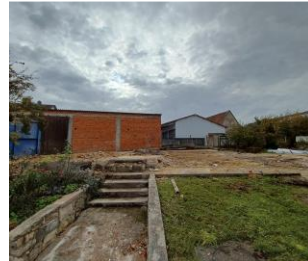
Gebäudeabbrüche und Grundstücksfreilegungen
