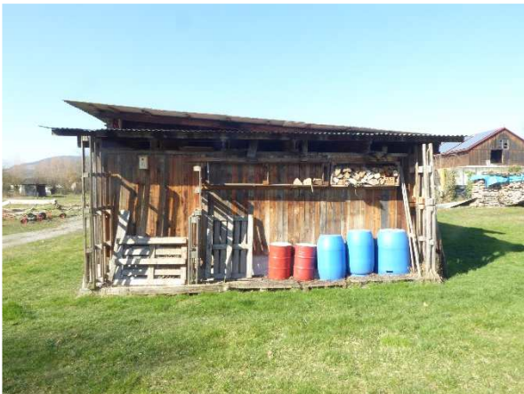
Abb. 3+4: Holzschuppen im Süden des Flurstücks
