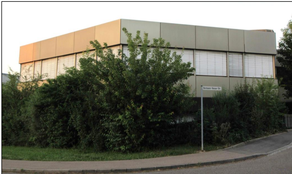
Abb. 6 Westlicher Gebäudeteil Ecke Schlossgarten/Hermann-Hesse-Straße
