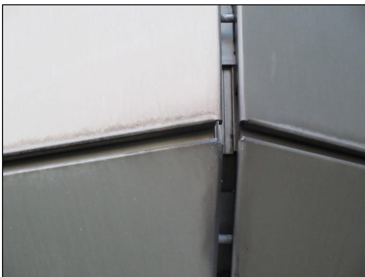
Abb. 7: Fassadenverkleidung aus Aluminium
