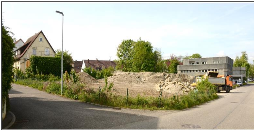
Abb. 5 Blick von der Bahnhof-/Ecke Wagnerstraße auf das Flst.Nr. 49 am 07.05.2019
